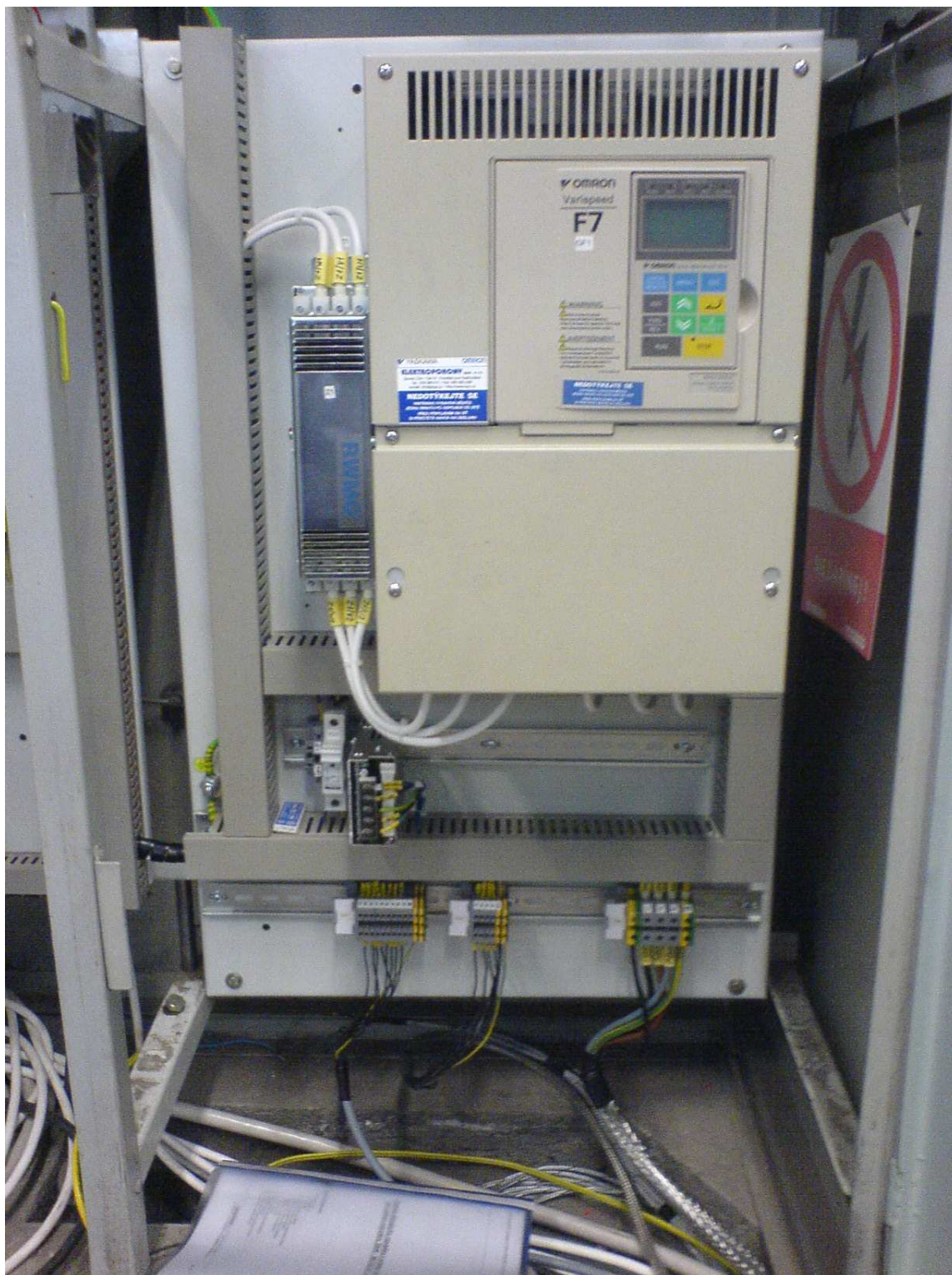
Obr.4: Instalace měniče do původního rozváděče – měnič 30kW.
