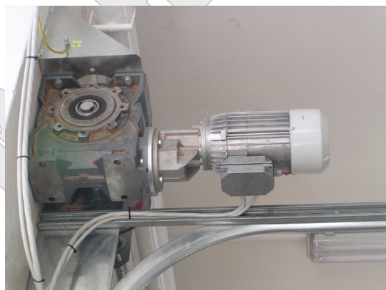
Upevnění motoru s převodkou
